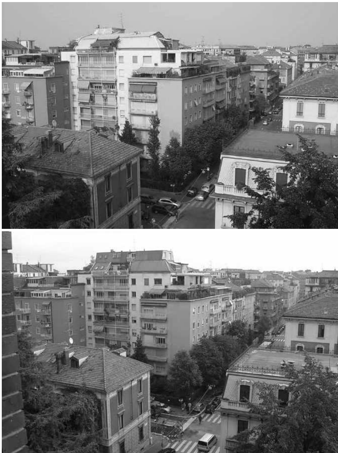
Figura 39 – Recupero abitativo del sottotetto: viste dello stato ante e post operam
